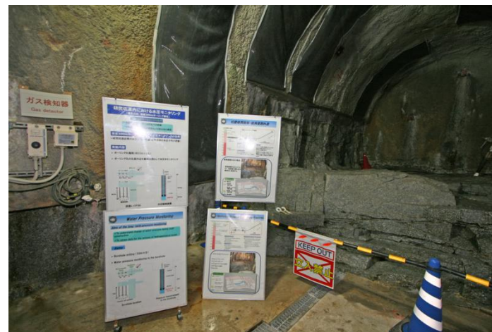
深度300mボーリング横坑(換気立坑) (説明用パネルの展示)
