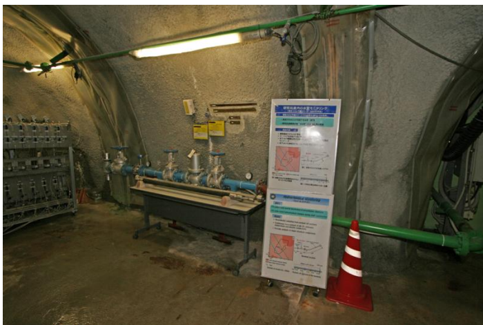
深度300m予備ステージ (説明用パネルの展示)
