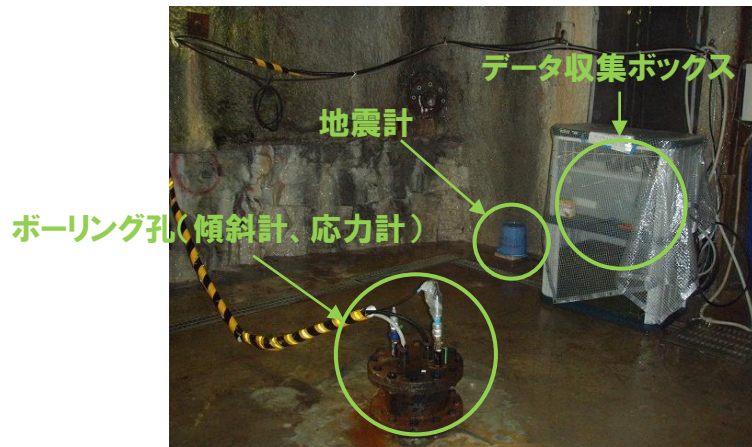
深度200mボーリング横坑(主立坑)
