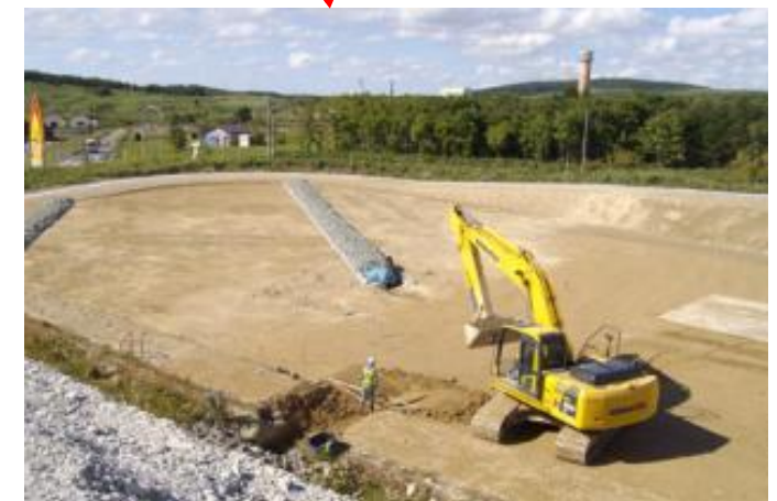
掘削土(ズリ)置場整備工事 (平成22年9月27日)
