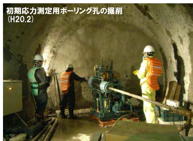
換気立坑140m小型試錐座
