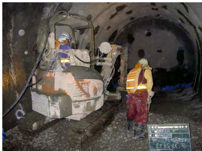
路盤施工状況
