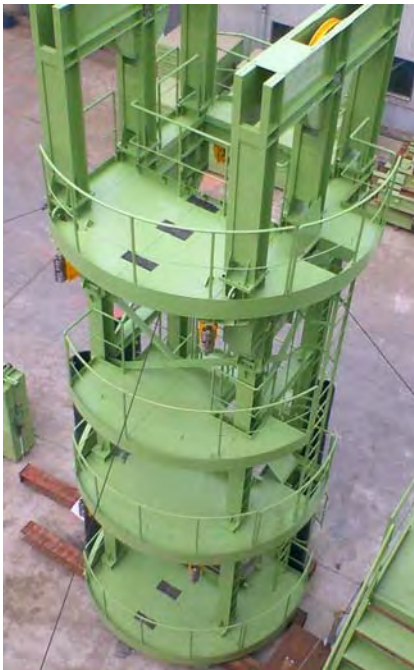
スcaffoldingの写真
