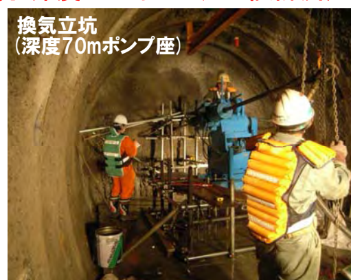
換気立坑 (深度70mポンプ座) 測定用ボーリング孔の掘削の様子
