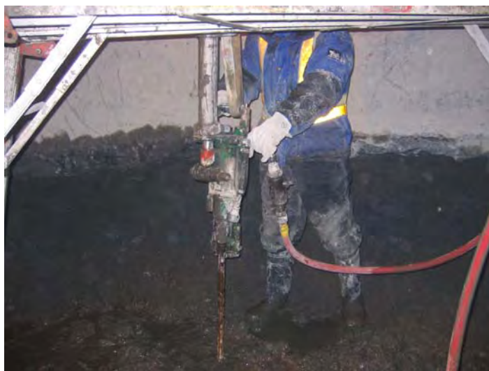
ガスチェックボーリング掘削
