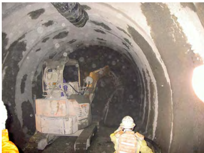
吹付コンクリート施工状況
