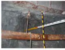
坑壁崩落の発生状況 (主立坑)
