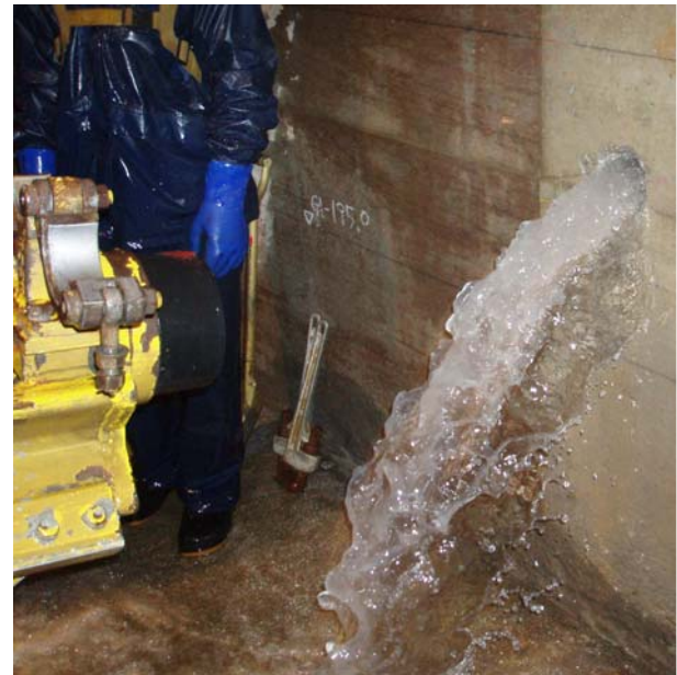
湧水状況(湧水量500l/min)
