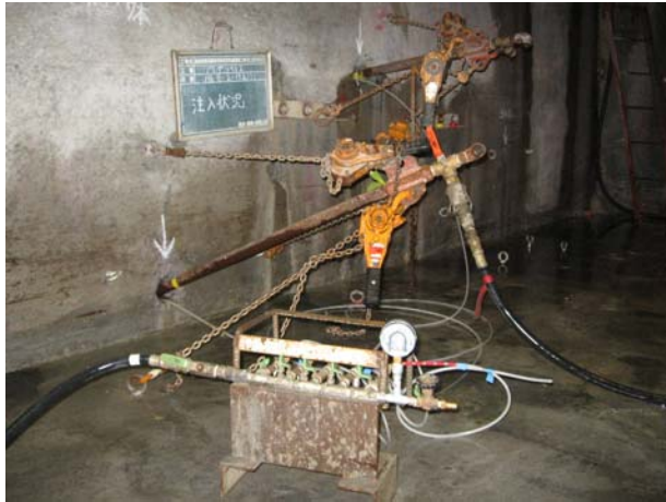
グラウト注入状況
