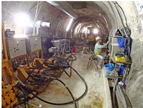
湧水抑制対策 (深度500m研究アクセス南坑道)
