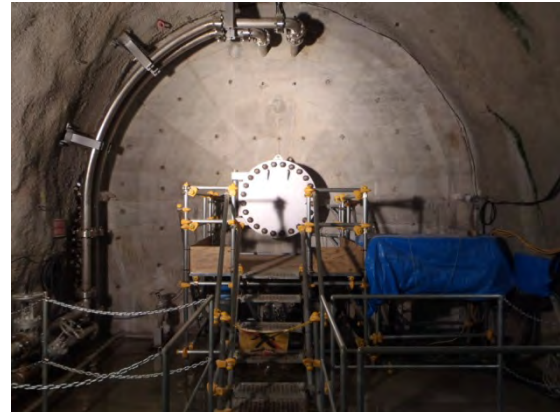
止水壁の設置作業 (深度500m研究アクセス北坑道)
