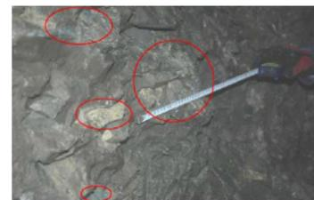
図2 立坑壁面でのグラウト材
