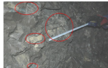
図2 立坑壁面でのグラウト材
