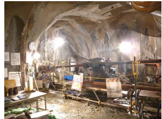
研究アクセス南坑道 先行ボーリング現場
