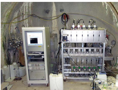
地下水モニタリング
