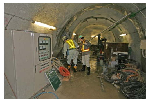
深度300m 11m計測横坑
