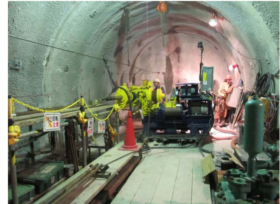
研究アクセス北坑道 先行ボーリング現場
