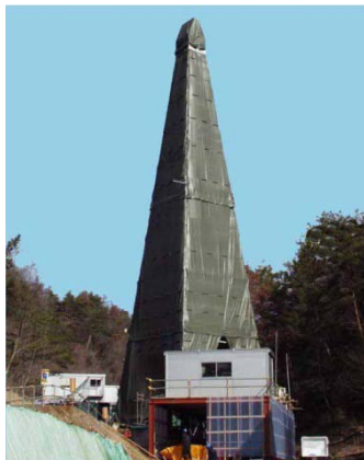
ボーリング調査
