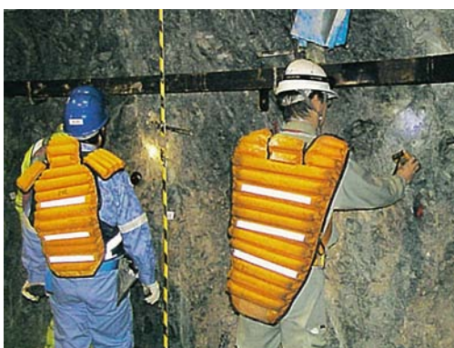
壁面地質調査
