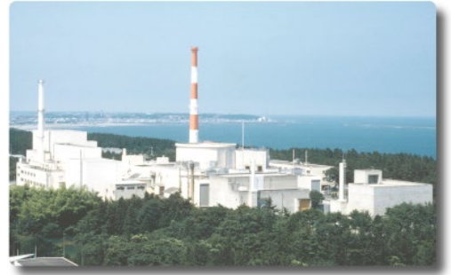
高速実験炉「常陽」
