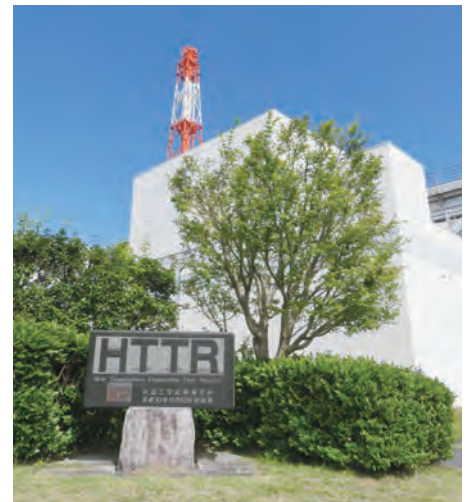
HTTR（高温工学試験研究炉）
