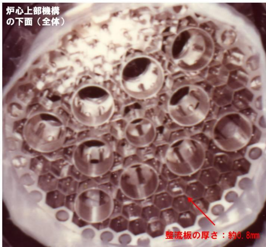
炉心上部機構の外観（建設時に撮影）
