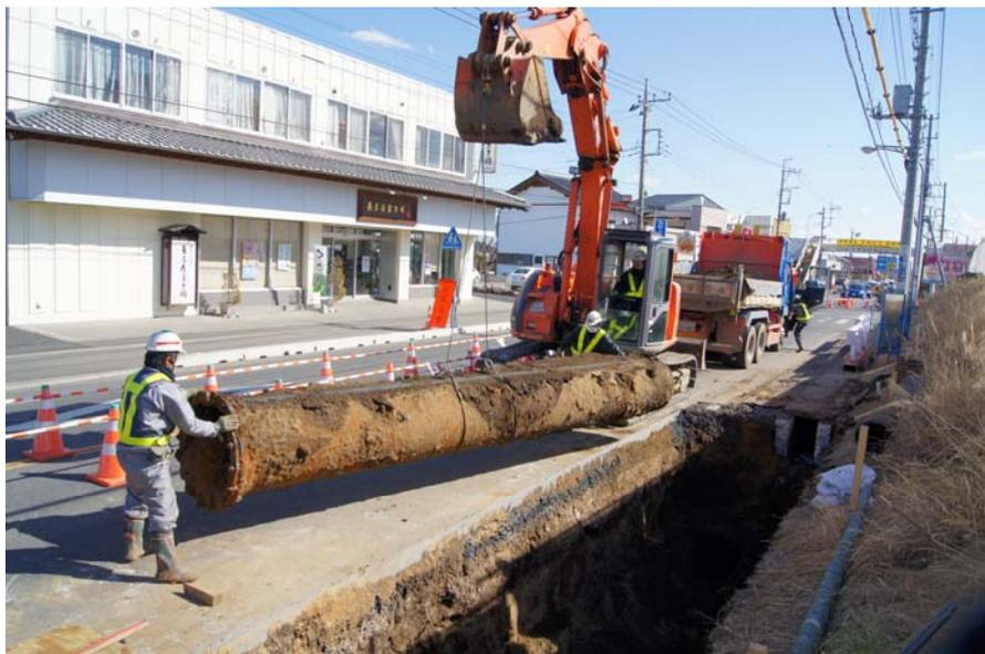
写真 2. 11. 4-1 導水管撤去状況 (村松北地区原研道路)
