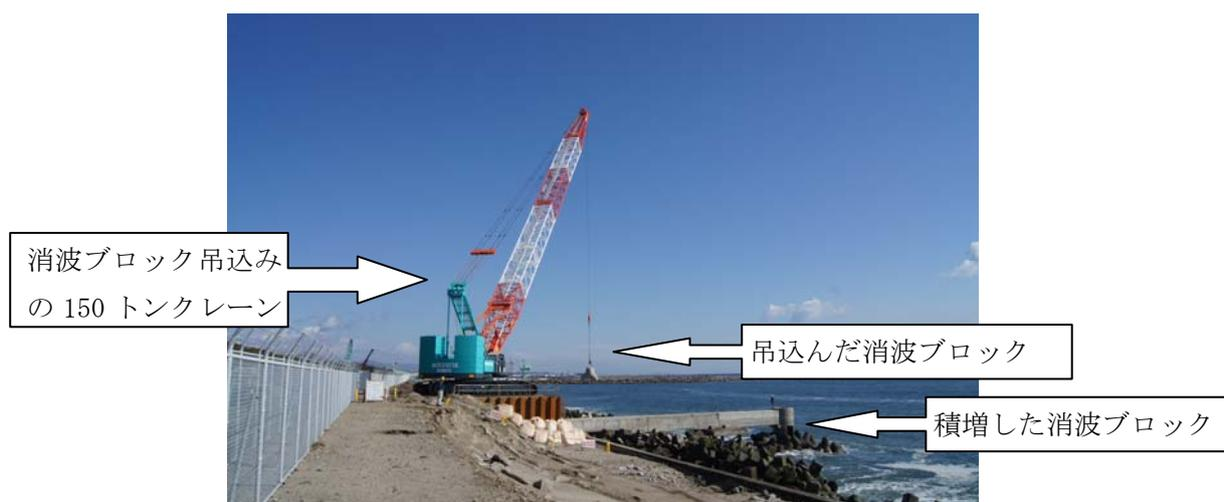
写真 2. 12. 3-2 第1放流渠の放水口周囲に消波ブロック積増し
