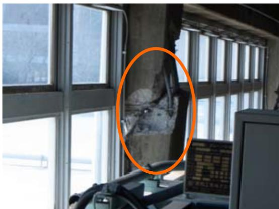
写真 2.12.4-2 工作工場南側高層部柱破損
