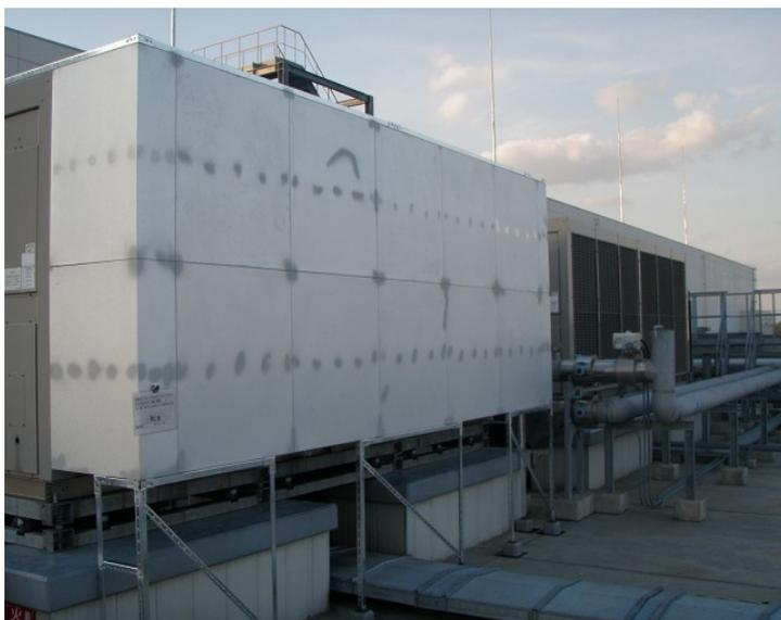
写真 2.1.21-4 ウィンドバッフル設置後
