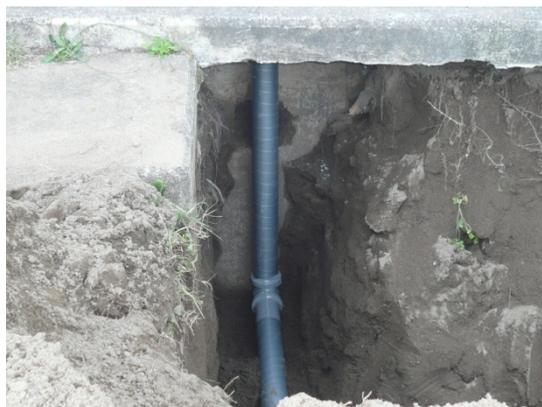
写真 2.8.2-2 一般排水配管 補修後
