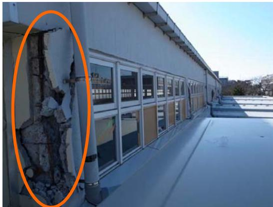
写真 2.12.4-1 工作工場北側高層部柱破損
