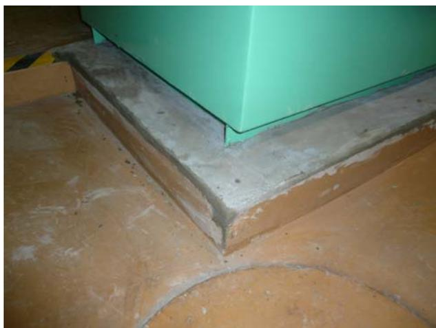
写真 2.1.18-2 フィルタユニット基礎部（補修後）
