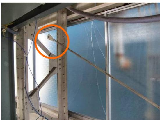
写真 2.12.4-4 機械化工特研ブレース破損
