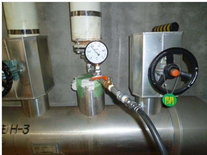
写真 2.1.9-2 試験圧力(約 0.4MPa)
