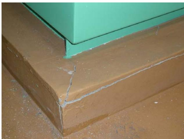
写真 2.1.18-1 フィルタユニット基礎部（補修前）
