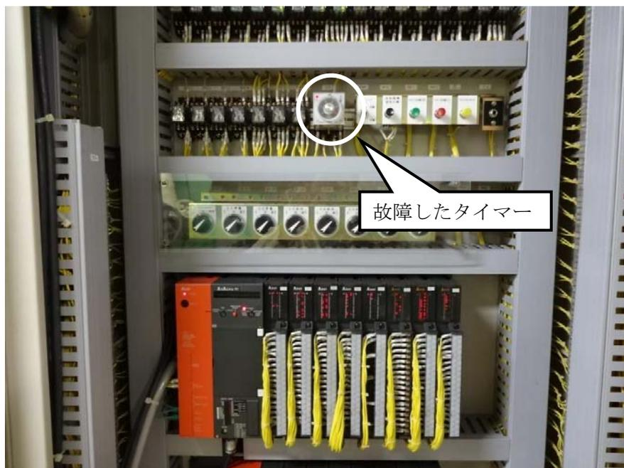
写真 2.8.4-1 タイマーの故障が発生した自動制御盤 (CP-201-3)
