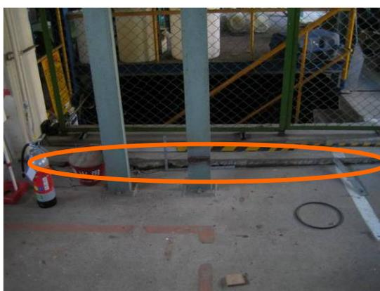
写真 2.12.4-5 機械化工特研床陥没
