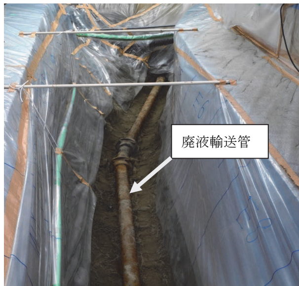
写真 2.3.1-2 廃液輸送管敷設状況
