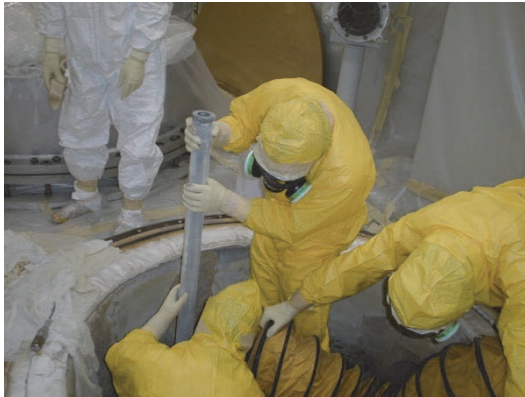
写真 2.3.1-3 CF エlement 交換作業
