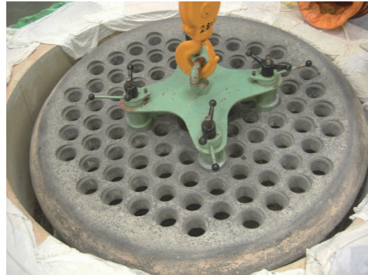
写真 2.3.1-4 支持プレート交換作業
