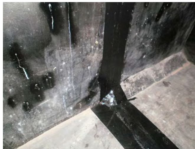
側壁部応急処置状況(平成23年6月13日)
