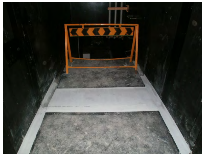
恒久復旧状況(平成24年3月28日)
