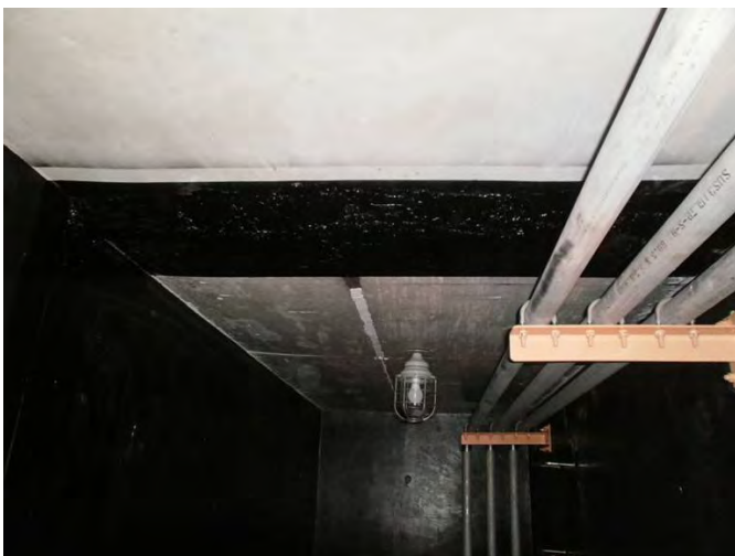
天井部応急処置状況(平成23年6月13日)
