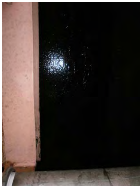
側壁部応急処置状況(平成23年6月13日)
