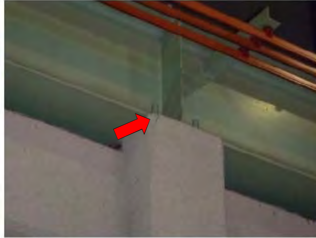
炉-40 第2廃棄物処理棟 クレーンレールベース部及び支柱上部の損傷
