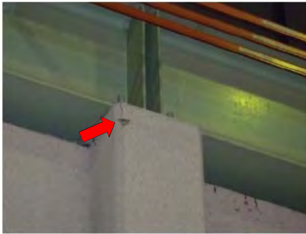
炉-40 第2廃棄物処理棟 クレーンレールベース部及び支柱上部の損傷
