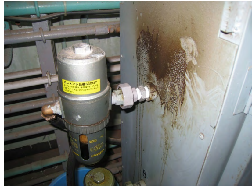
破損箇所(処置後)
