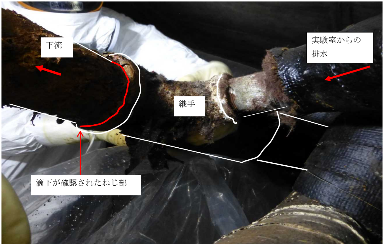
写真1 廃液配管と継手部の保温材除去状況 (A部)
