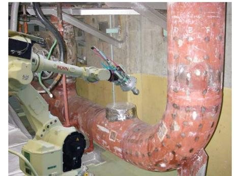
レーザ切断技術の配管への適用(例)
