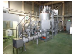
サイクル施設 火災実験 装置 (ACUA)
