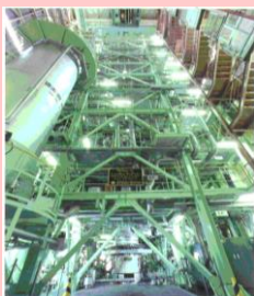
大型非正常試験装置 (LSTF)
