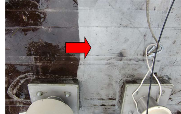
MP屋根除染の様子 (水谷ほか, 2011)
