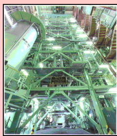
大型非常試験装置 (LSTF)
