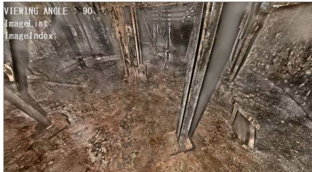
2号機格納容器内ペDESTAL底部
