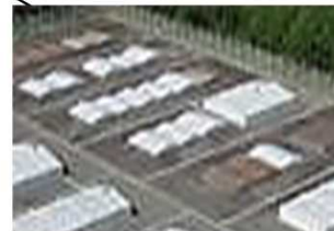
保管廃棄施設・M-1
