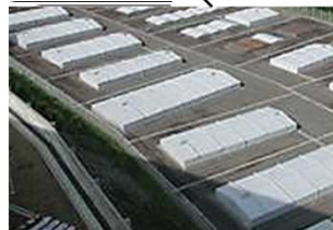
保管廃棄施設・M-2
