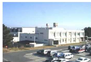
第3廃棄物処理棟
