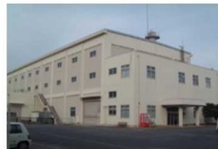
第2廃棄物処理棟
