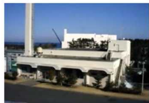
第1廃棄物処理棟
