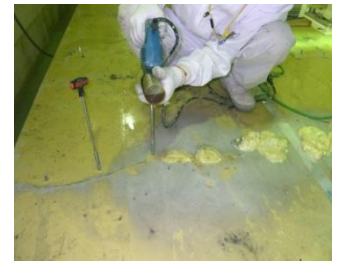
↑ トンネルに生じた微細なひび割れの隙間を ウレタン樹脂を注入して塞ぎ、地下水の漏水を 防ぐ。排水作業も復電と共に再開した。
