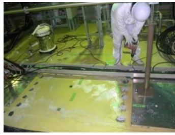
↑ トンネルに生じた微細なひび割れの隙間を ウレタン樹脂を注入して塞ぎ、地下水の漏水を 防ぐ。排水作業も復電と共に再開した。
