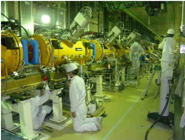
↑ 加速器の精密な位置合わせ(アライメント)作業。レーザー光線を利用した計測器 で、1mm以下の精度で位置を合わせる。(左:リニアック、右:50GeVシンクロトン)
