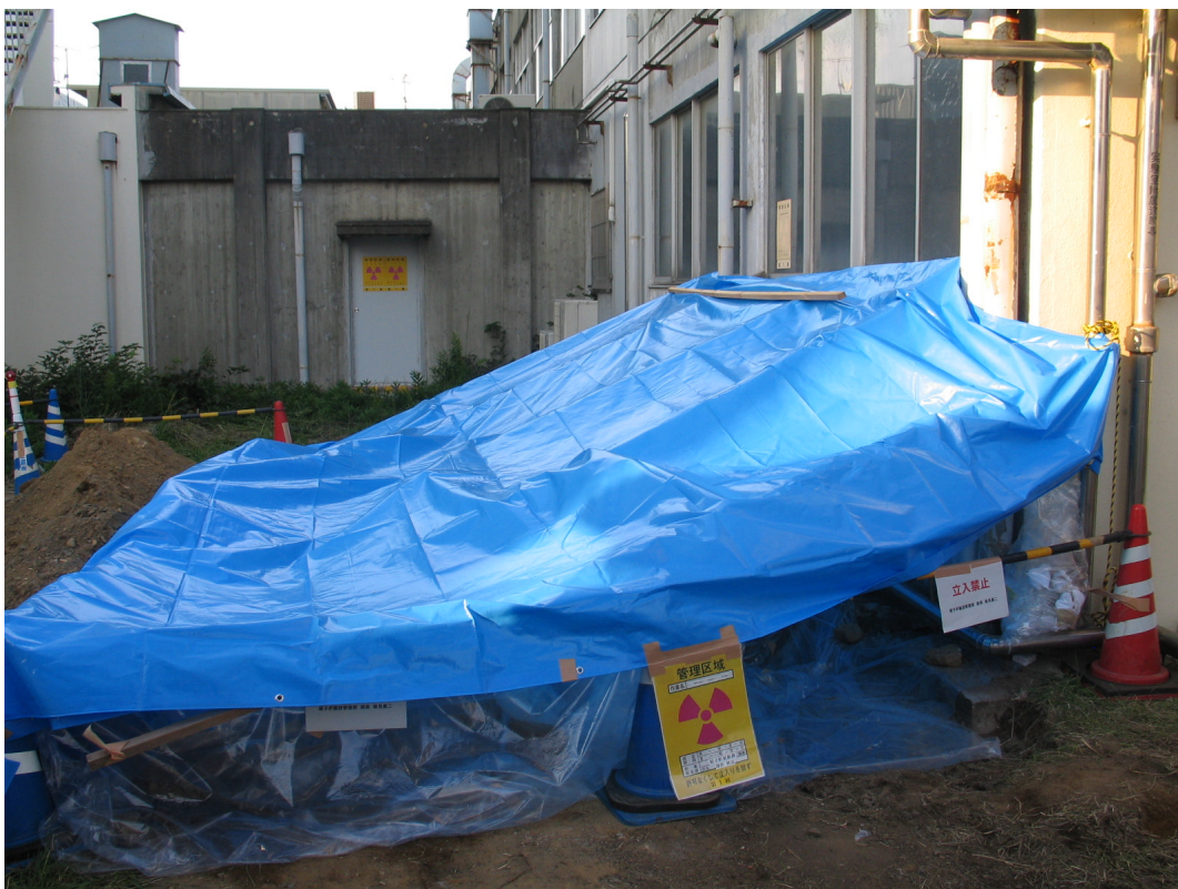
図6 応急処置の状況
