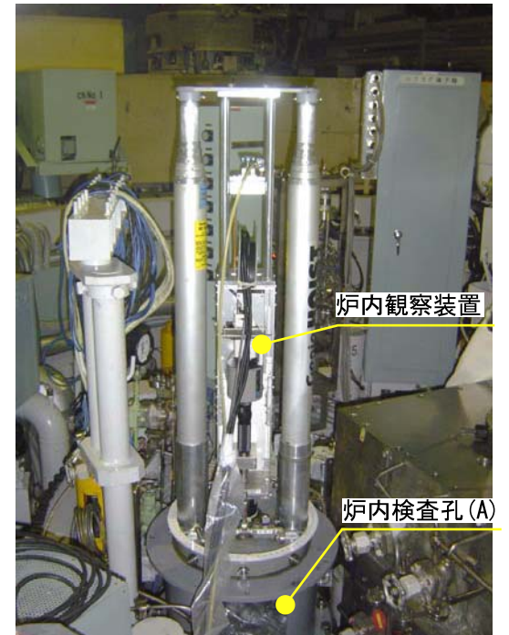
炉内検査孔(A)での観察作業の状況
