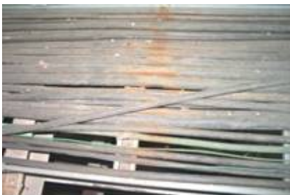
写真-2.4 ケーブルラック (全て平成19年2月16日撮影)
