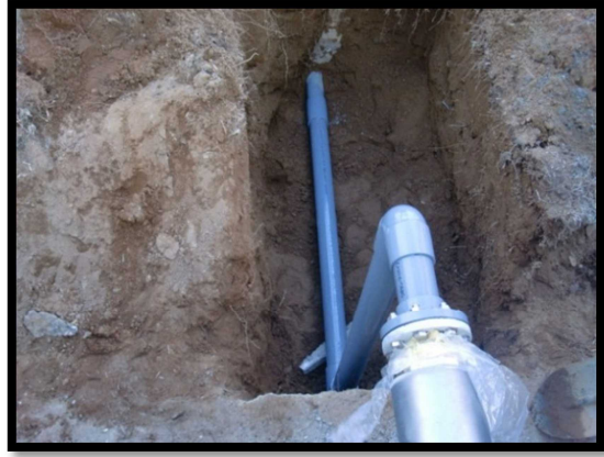
排水管復旧後（補機冷却水設備 A 系統側）
