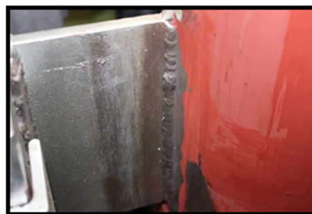
配管とシューの接合部の異常なし
