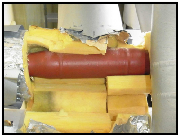
保温材取り外し後の配管目視点検
