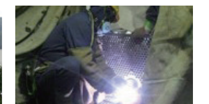
原子炉周辺機器の解体
