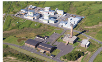
幌延深地層研究センター全景
