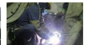
原子炉周辺機器の解体
