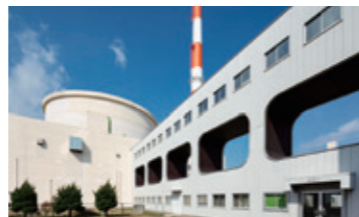
高速実験炉「常陽」
