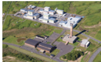
幌延深地層研究センター全景
