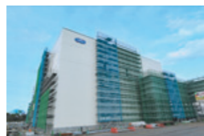
放射性物質分析・研究施設第1棟の建設状況
