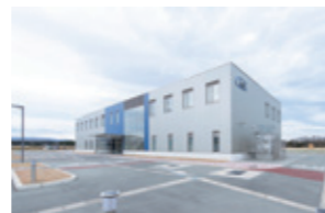
国際共同研究棟の外観
