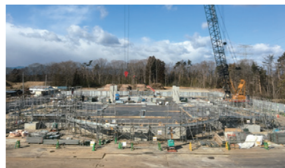
施設管理棟建設地全景(2017年2月21日撮影)
