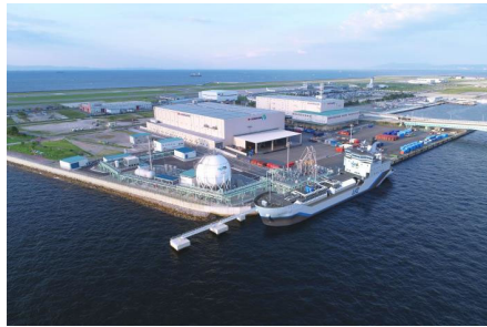
液化水素の荷揚基地
