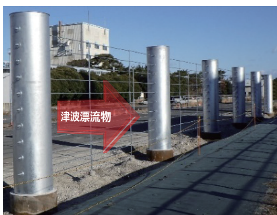
津波漂流物による被害を防ぐ防護柵（引き波用）の設置
