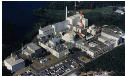
高速実験炉「常陽」
