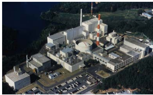
高速実験炉「常陽」
