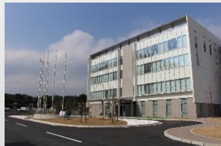
檜葉遠隔技術開発センター ・研究管理棟(H27/9/24～) ・試験棟(H28/2～)
