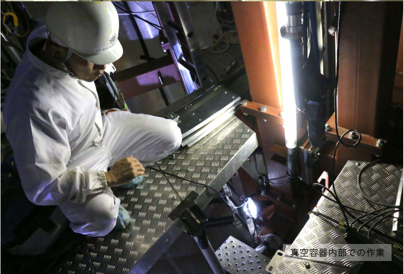
真空容器（40度セクター）の吊り込み
