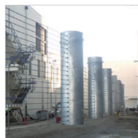
津波によって流された漂流物の衝突から防護する津波漂流物防護柵
