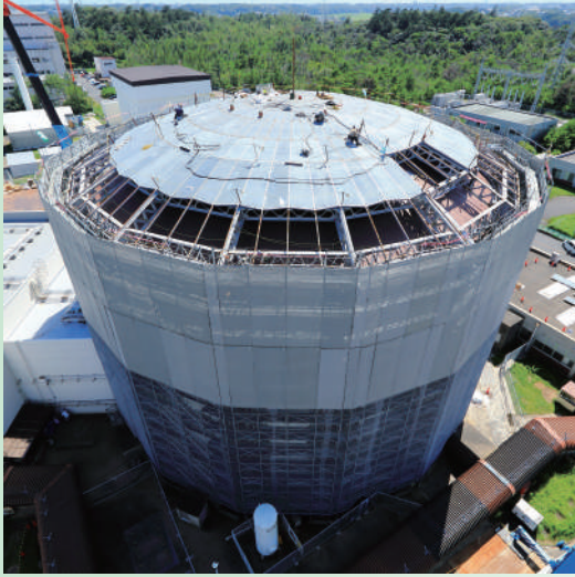
原子炉建家の屋根（左）と排気筒（右）の補強工事の様子
