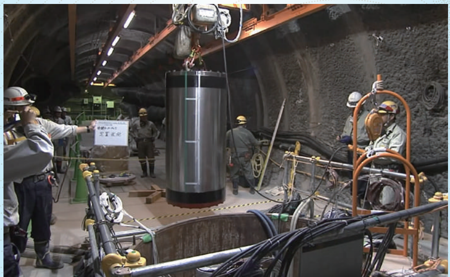
人工バリア性能確認試験の様子
