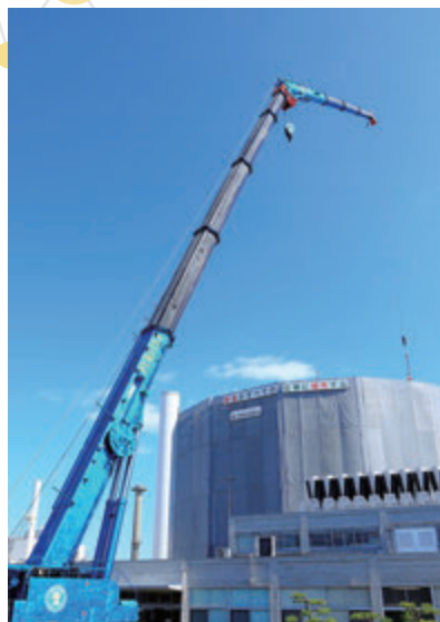
耐震補強工事をして、2021年2月の運転再開を目指しています
