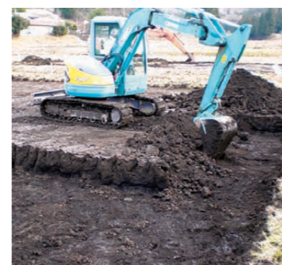
除染モデル実証事業で行った重機による田畑の除染(表土除去)
