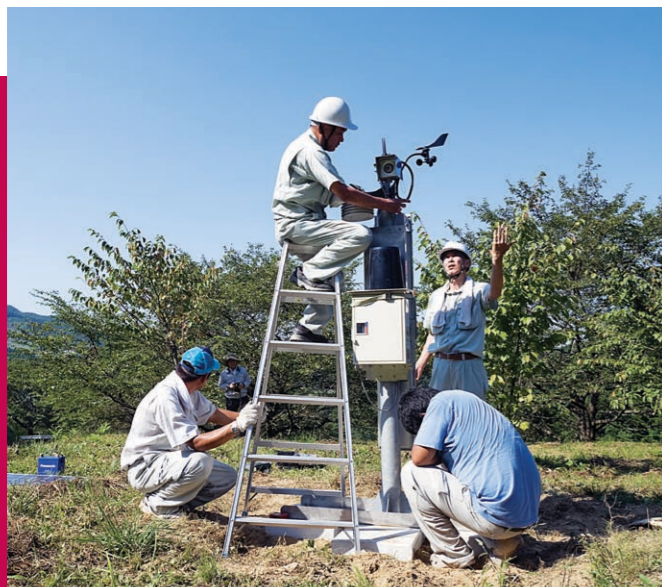
放射線測定装置を設置する様子
