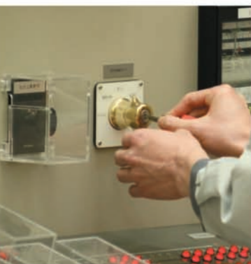
●原子炉モードスイッチ 「停止」、「燃料交換」、「起動」、「メンテナンス」の4つのモードがある。
