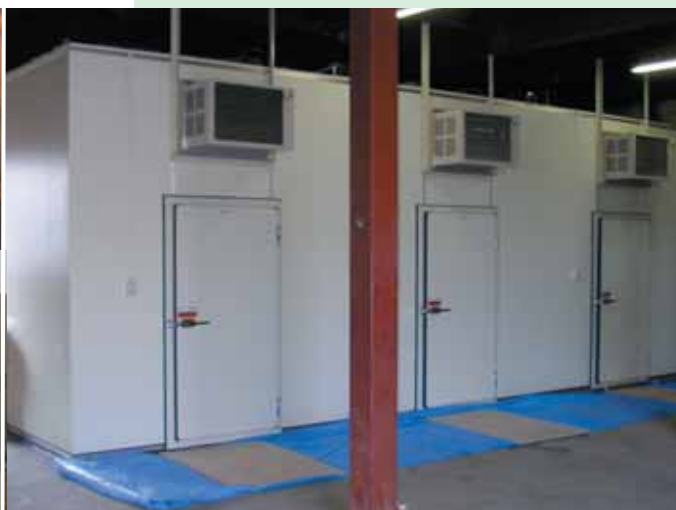
●温度、湿度を調整して酒を熟成させる熟成室の外観と内部の様子。
