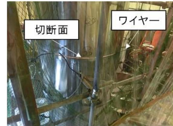
ダイヤモンドワイヤーソーによる遠隔解体
