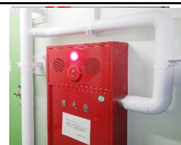
溢水源となる配管の補強例
