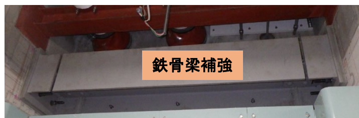
鉄骨梁補強箇所(天井パネル内)
