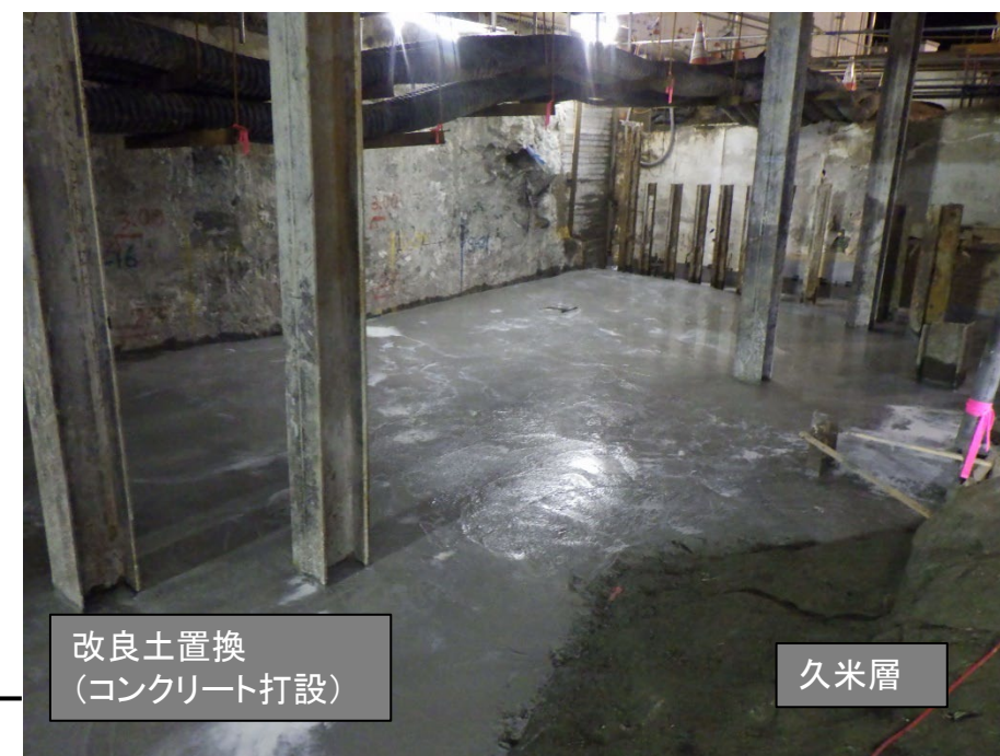
地盤改良工事の状況(令和6年2月)
